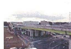
A 倉庫西側
